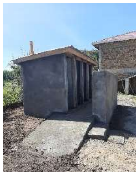
Splitter nytt latrinebygg.
