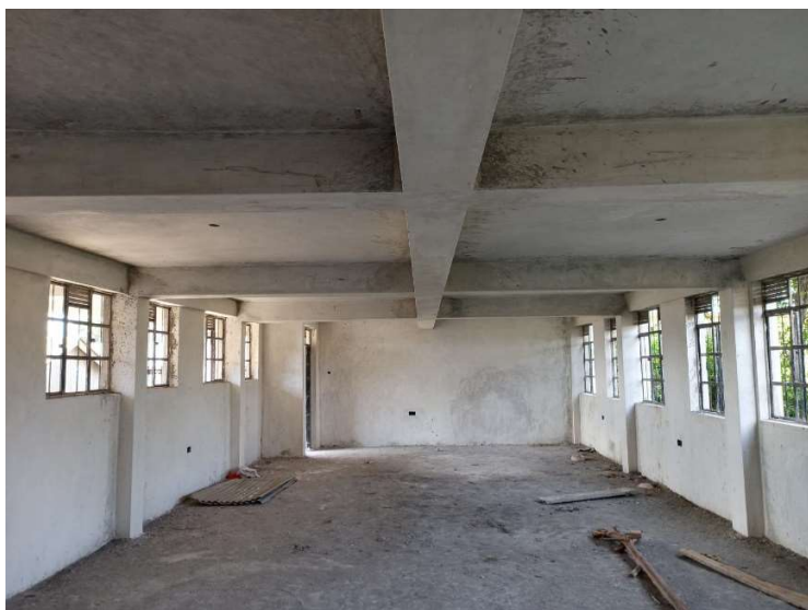
Det store rommet som skal kunne deles til to klasserom
