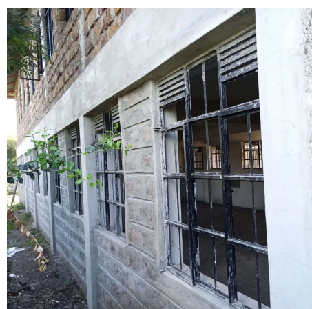
De nye vinduene.
